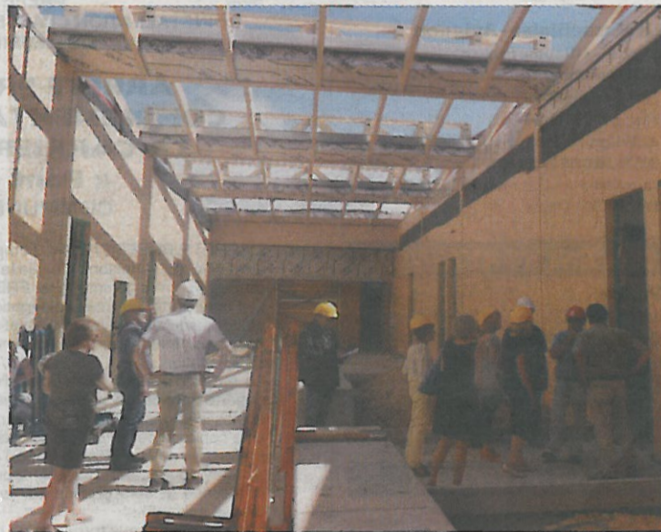
Visite sur le chantier du futur éco-campus Méditerranée. NV
