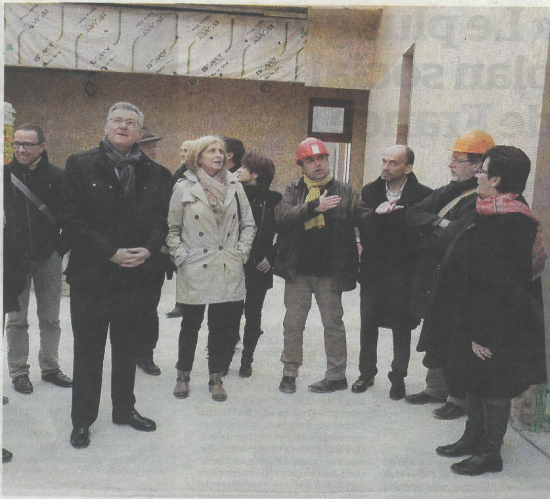
Sur le chantier de l'Eco-campus qui ouvrira ses portes en septembre prochain. NV
